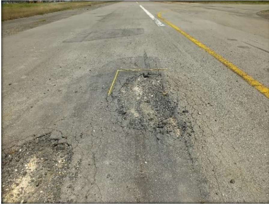
Fotografías No. 7-8: Izquierda-Canal aparentemente en zona de seguridad a 50mts de la pista. Derecha mal estado superficie asfáltica aeródromo SKPA
